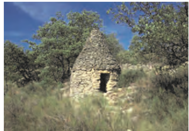
Cabanon pointu des Alpes-de-Haute-Provence à Mane
