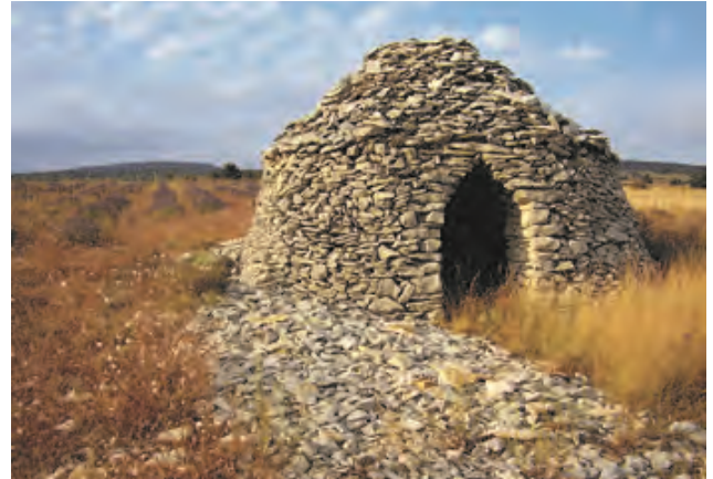
Ferrassières : cabane au corps de base cylindrique à fruit marqué et à la couverture conique de lauses très défilée.
