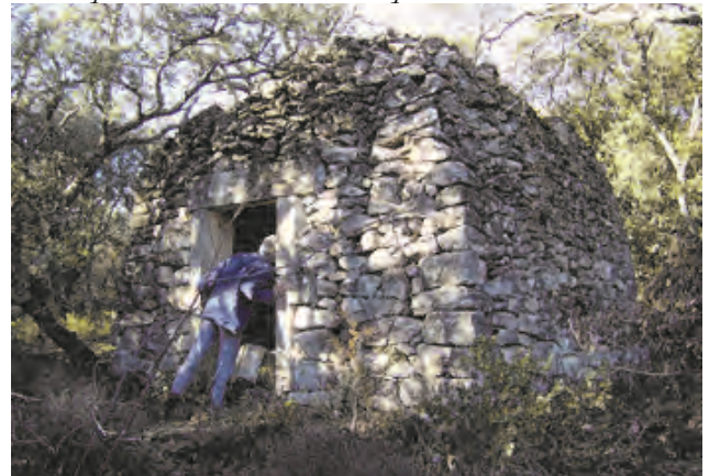
Grignan : cabane de carrier en forme de pyramide aux faces curvilignes; l'entrée a un encadrement de pierres de taille.
