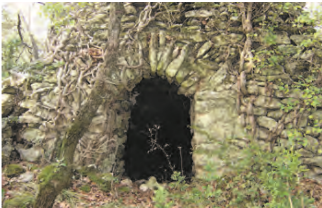
Grignan : cabane à l'entrée couverte par un arc clavé de lauses.
