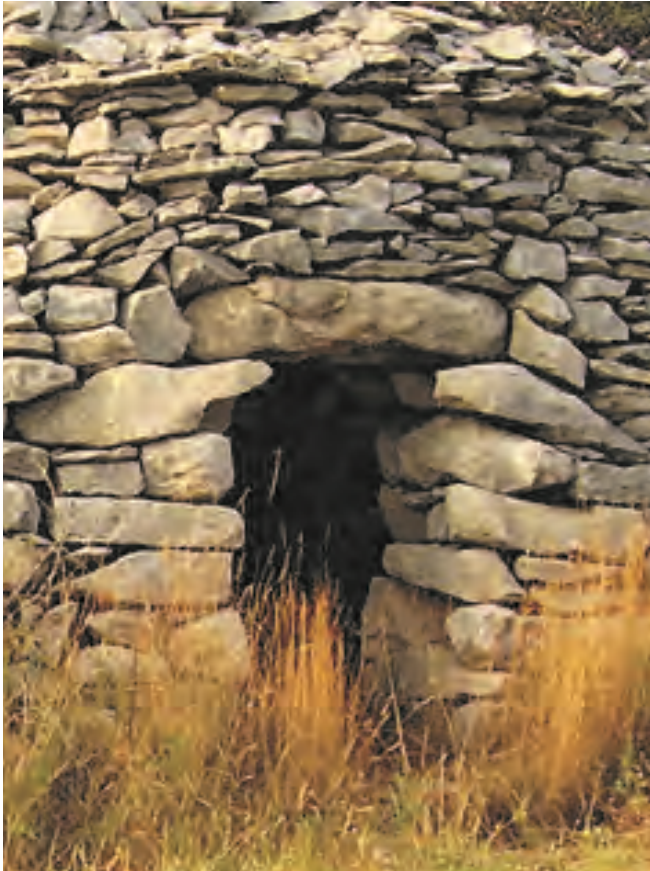
Ferrassières : entrée couverte d'un linteau porté de chaque côté par une pierre encorbellée et relevée
