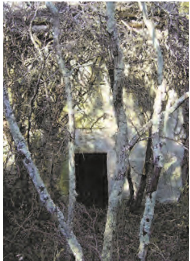
Grignan Cabane de carrier; encadrement d'entrée en pierres de taille
