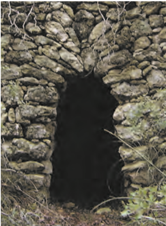
Grignan Entrée aux côtés convergents et au revêtement clavé
